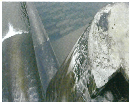
まこし 馬越頭首工土砂吐ゲート堰柱
