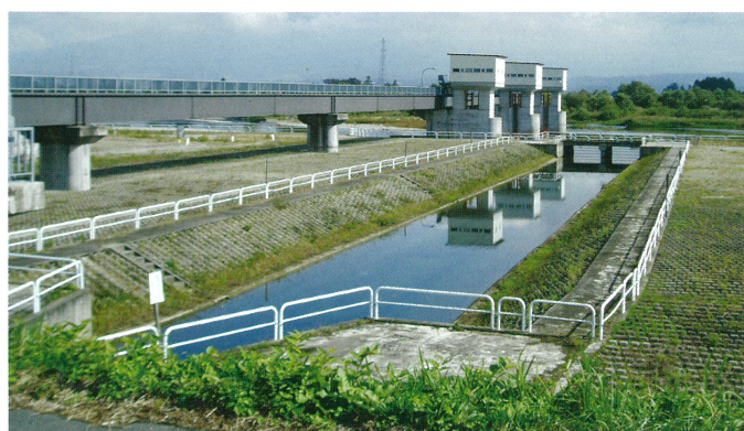
とみかわ 富川頭首工(平成5年に完成)
