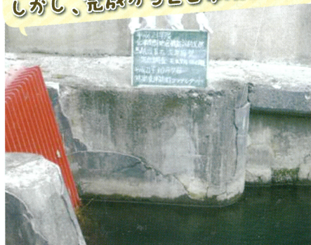
まこし 馬越頭首工左岸取水口
