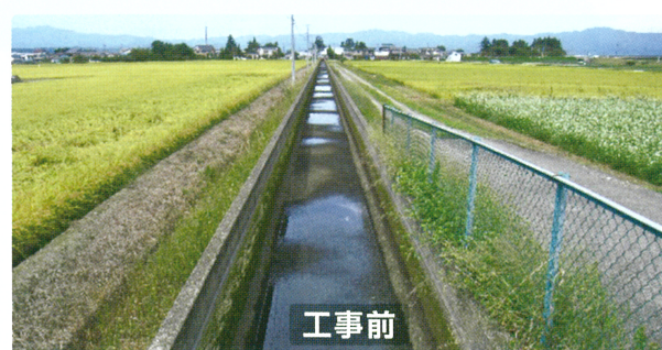
とみかわかんせん ようすい ろ え び さ わ 富川幹線用水路 (会津坂下町海老沢地区)
