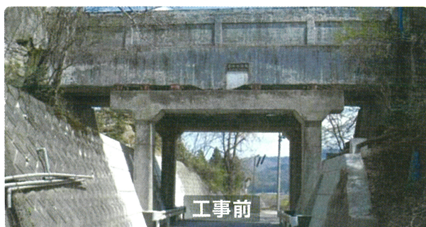
おおかわかんせん ようすい ろ おおいし 大川幹線用水路 (会津美里町大石地区)
