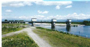
とうしゅこう 頭首工
