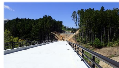
農道整備（いわき地区）
