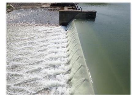
整備後の上仁井田頭首工
