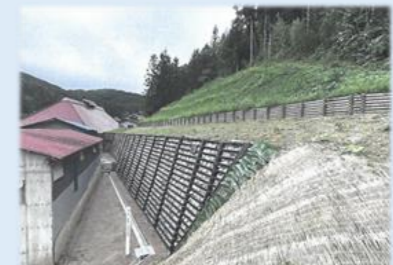
土留工、山腹工 (戸沢地区)
