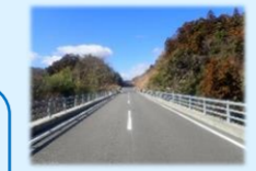
整備中の農道（いわき地区）
