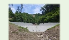
治山ダム(江尻地区)
