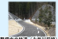
整備中の林道（永井川前線）
