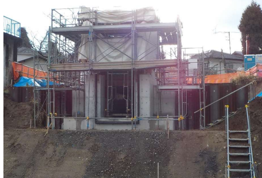
桜木排水樋門工事の進捗状況（右岸）
