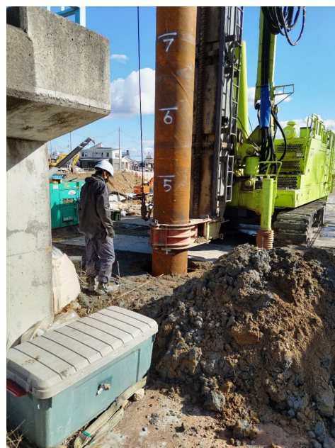
幕ノ内橋下部工杭基礎施工の様子
