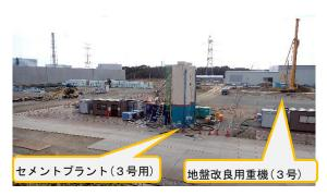
(写真3-1) 地盤改良用重機 (3号) 及びセメン トプラント (3号用) の状況
