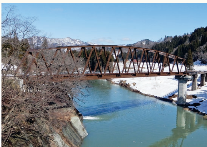
復旧工事が完了した第七只見川橋梁
