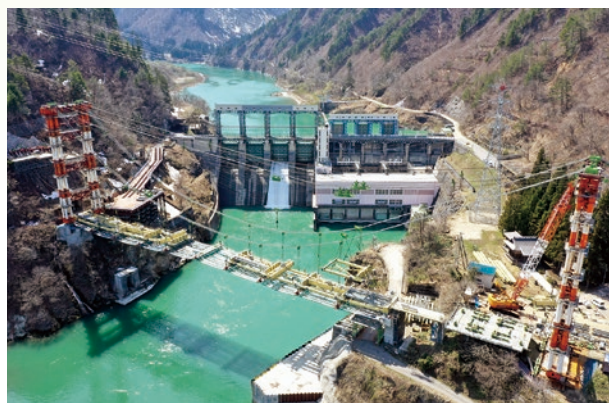
復旧工事中の第六只見川橋梁
