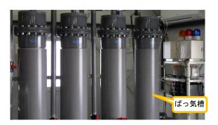
(写真2-3) 海洋生物由来のアンモニアを分解す る生物ろ過槽(3槽)およびばっ気 槽(1槽)
