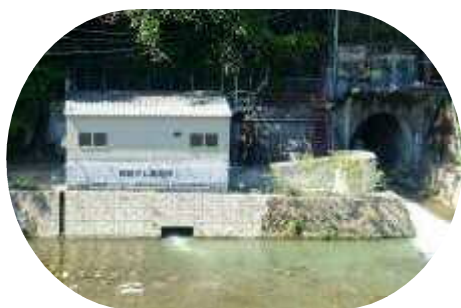
四時ダム発電所全景
