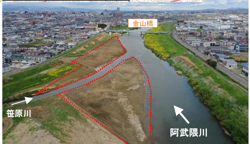
掘削後 (R4.4月撮影)
