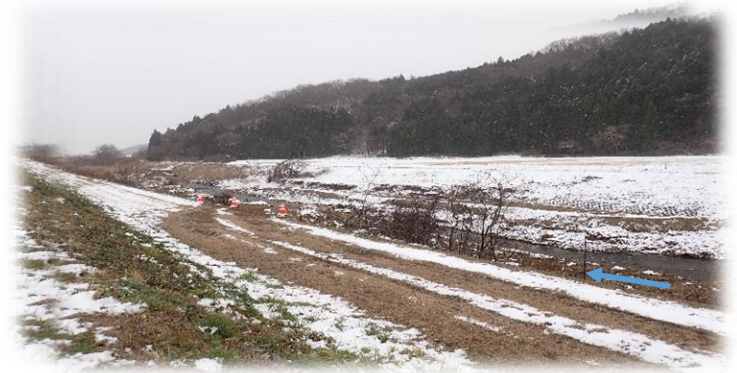
上流(左岸)から下流を望む
