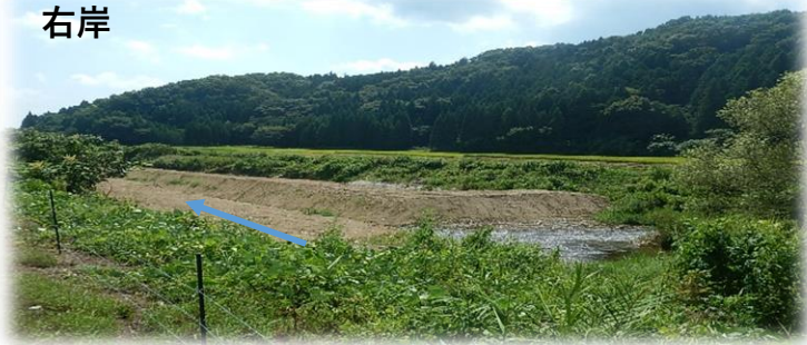
上流(左岸)から下流を望む
