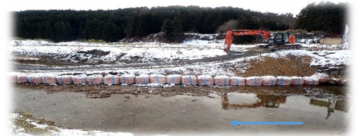
上流(左岸)から下流を望む
