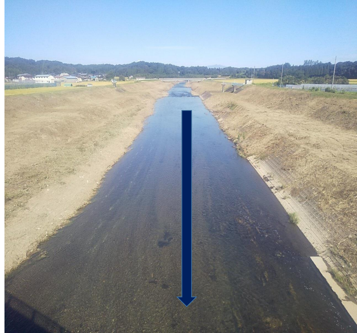
赤城橋下流（施工後）
