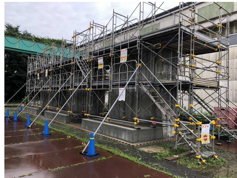
写真 1. 試験体構築完了
