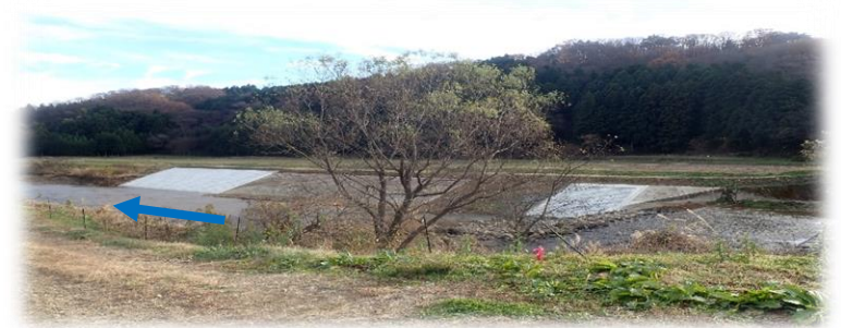
上流(左岸)から下流を望む
