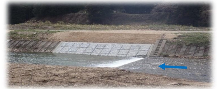
上流(左岸)から下流を望む
