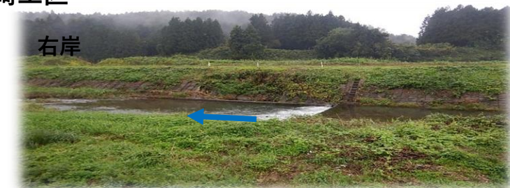
上流(左岸)から下流を望む
