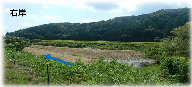
上流(左岸)から下流を望む
