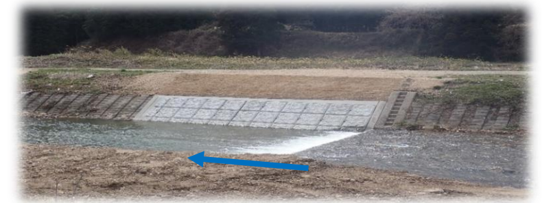
上流(左岸)から下流を望む
