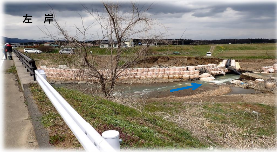
里橋から下流側 右岸から左岸を望む
