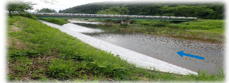
上流から下流を望む (株) 八木沼組
