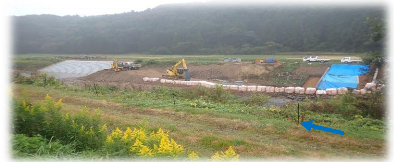
上流(左岸)から下流を望む
