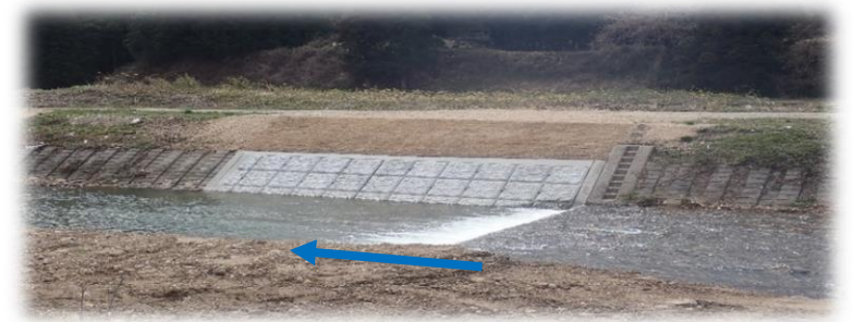
上流(左岸)から下流を望む
