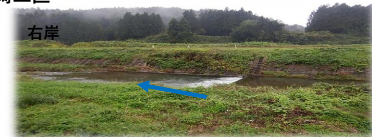
上流(左岸)から下流を望む
