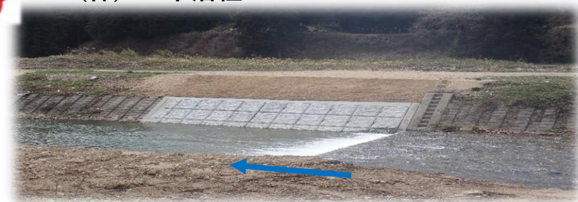
上流(左岸)から下流を望む
