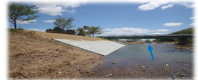
上流から下流を望む (株) 八木沼組
