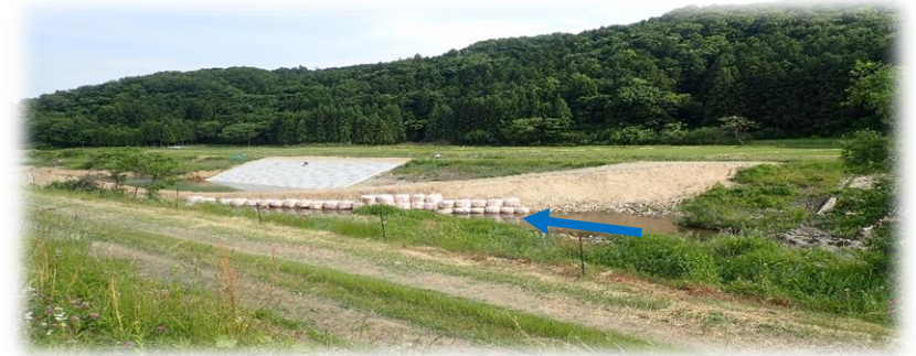
上流(左岸)から下流を望む
