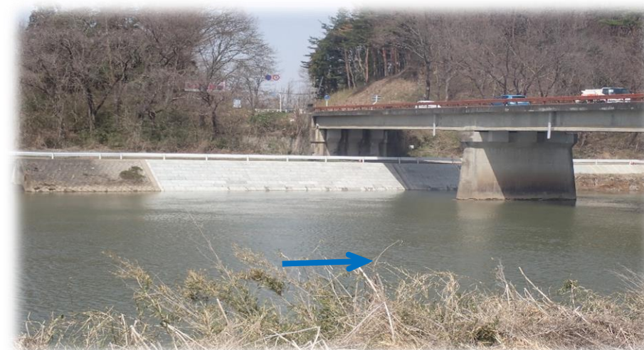
右岸から左岸を望む
