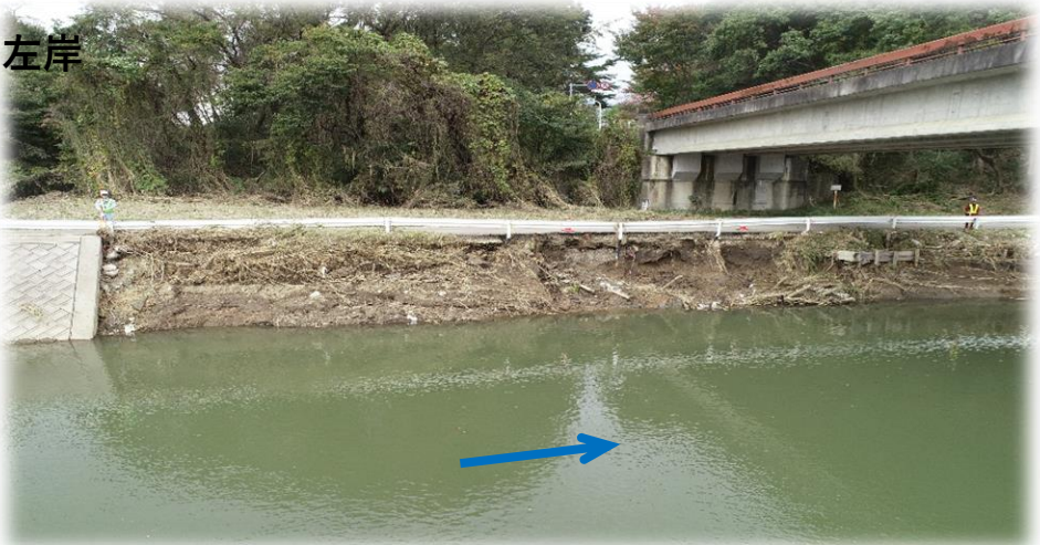
右岸から左岸を望む
