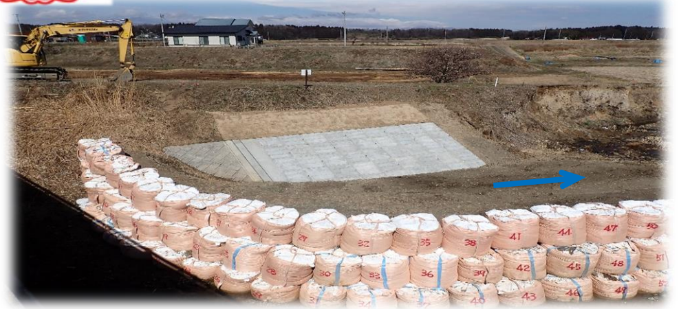
里橋から下流側 右岸から左岸を望む
