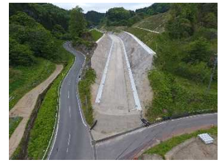
ふくしま復興再生道路 (国道349号)
