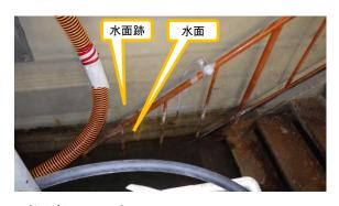
(写真2-3)6号機タービン建屋地下階の滞留水の 状況(令和3年4月19日撮影)
