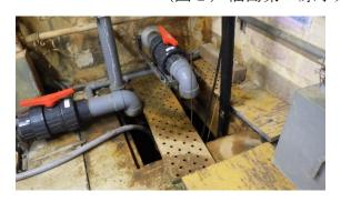
(写真1-1) 地下水流入箇所の状況 (6号機タービン建屋地下階南西側) (令和4年5月13日撮影)
