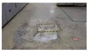
(写真3-1)電気品室床面の湧水の状況 (令和3年4月19日)
