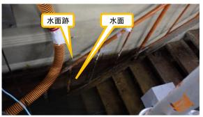
(写真2-4) 6号機タービン建屋地下階の滞留水の 状況(令和4年8月26日撮影)
