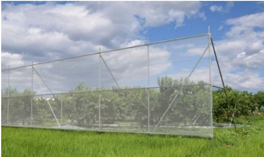
図. 防風ネットの設置状況
