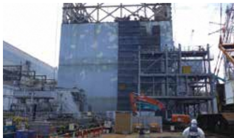
大型カバーの設置が進む1号機(現地駐在職員 撮影)
