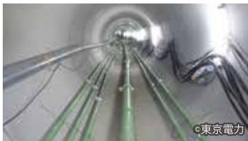
新たに整備された排水路
