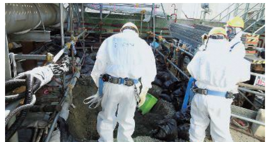
原子力安全対策課榎葉町駐在による現場確認
