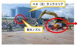
(写真 2 - 1) コンクリート構造物破砕作業ヤード の状況① (北東側から撮影)
