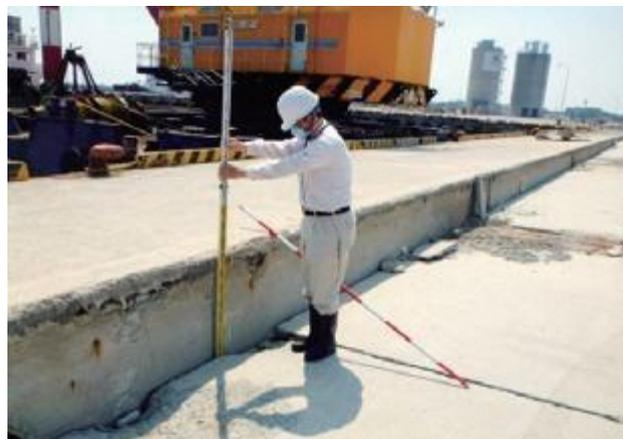
③ 岸壁背後のエプロン舗装沈下
