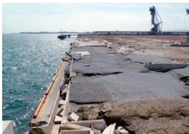
③ 岸壁エプロン舗装破損
