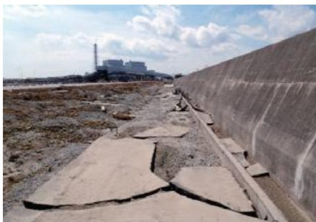
① 護岸水叩き舗装破損
