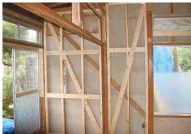
耐震改修の実施状況
