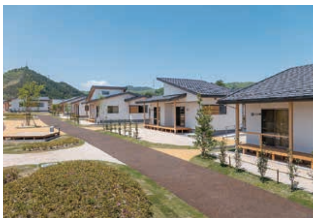
帰還者向け災害公営住宅等
