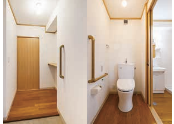
バリアフリー化された住宅 (段差解消・手すり設置)
