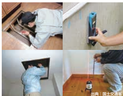
建物状況調査の実施状況
