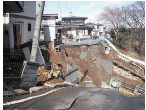
土砂崩れによる被災状況
