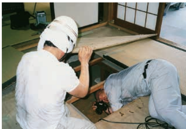
耐震診断の実施状況
