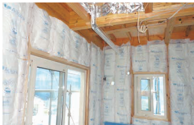
断熱改修の実施状況
