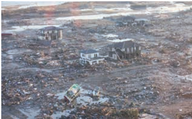
東日本大震災被災状況
