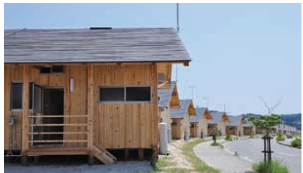
木造仮設住宅の供給
