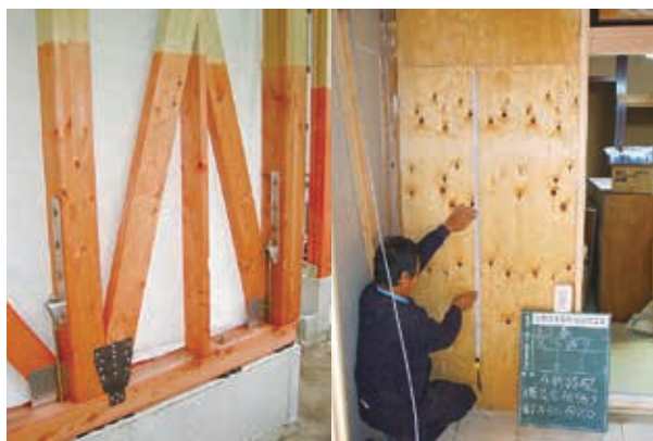
耐震改修の実施状況
