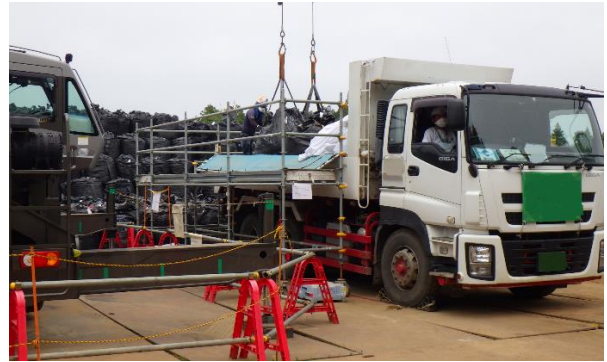
除去土壌等の積込作業
