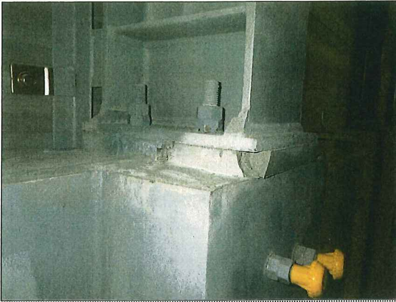
柱⑱ 主柱 左側
