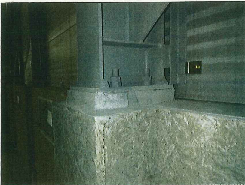
柱⑨ 主柱 右側
