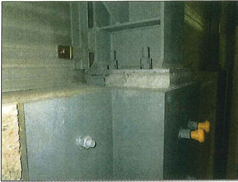
柱⑦ 主柱 左側
