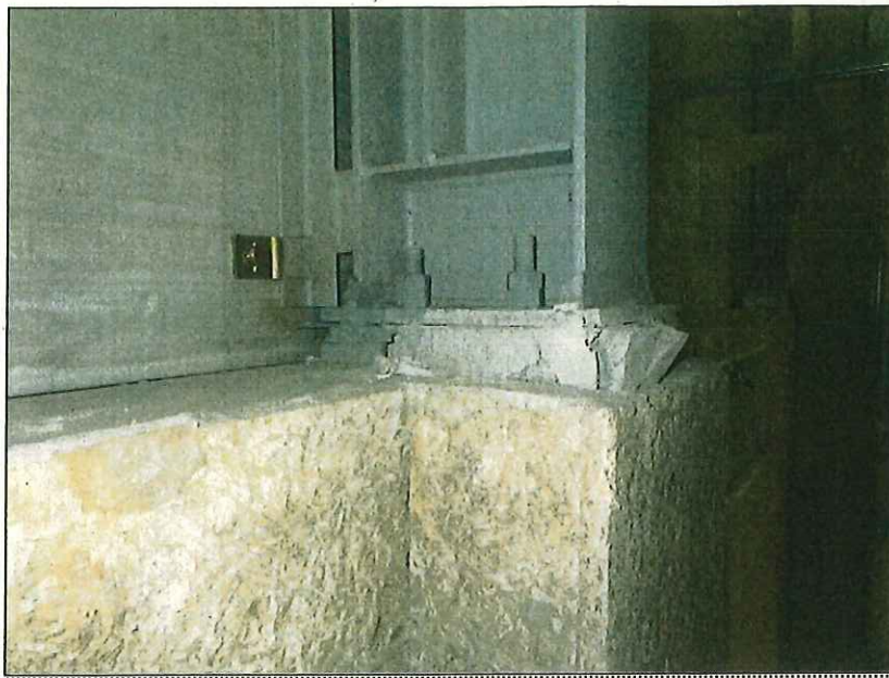
柱⑤ 主柱 左側
