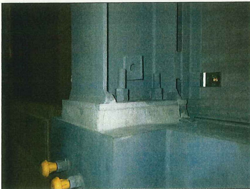
柱③ 主柱 右側
