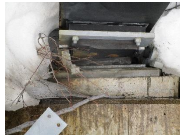
写真3：支承損傷
