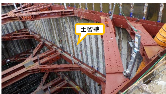
(写真3) 放水立坑工事の状況
