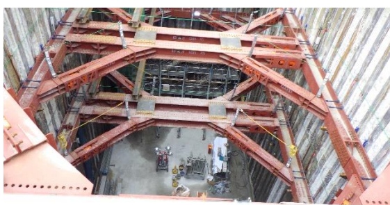
(写真4) 放水立坑内部の状況
