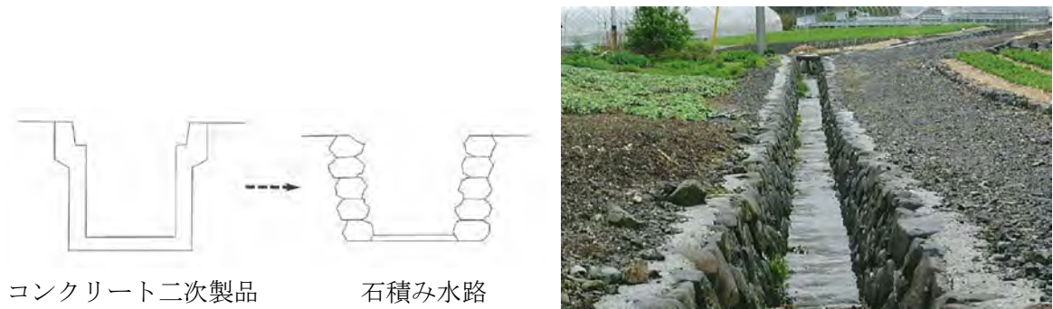
図-3.4.5 自然石を用いた水路護岸（底面はコンクリート張）
