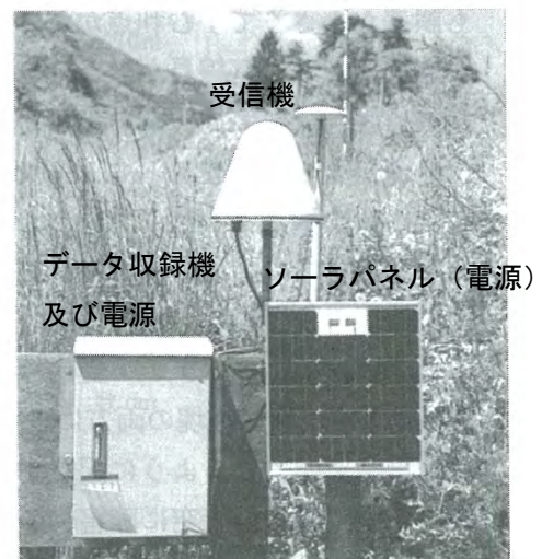
図-2.9.13 GNSS受信装置の設置状況の例
