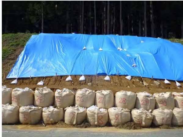
図-3.10.9 応急土留工の例（庄内あさひ地区（山形県））
