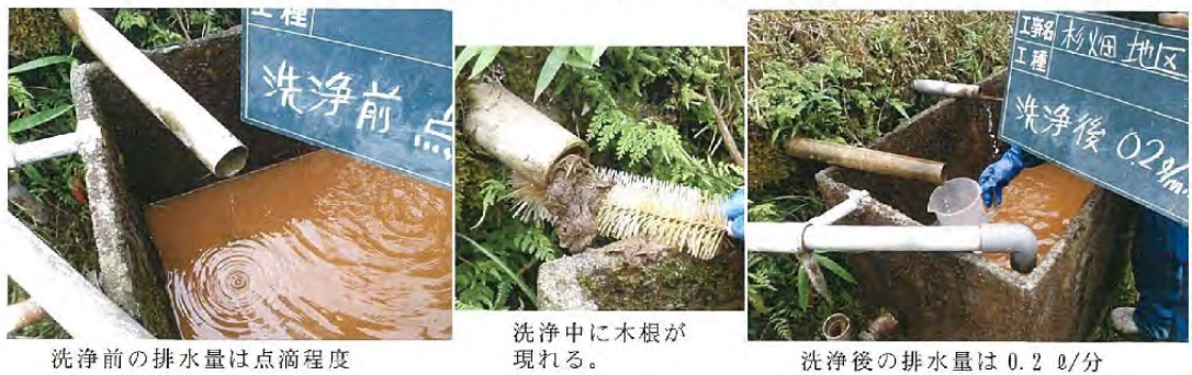
図-4.11.11 地元で行われている水抜きボーリングの孔内洗浄作業
