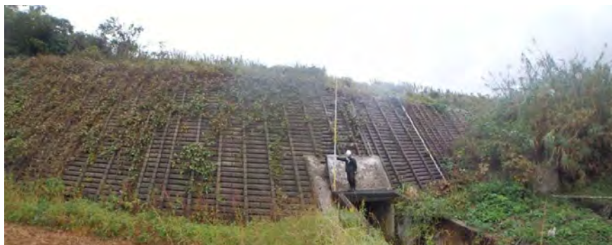
(c) 押え盛土末端部の土留工（井桁擁壁工）と暗渠工
