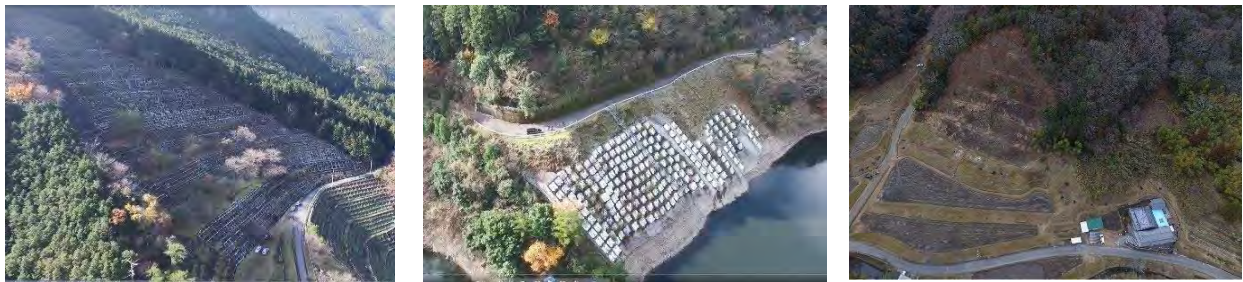
大迫ダム左岸ブロック 大迫ダム人見谷ブロック 北水上区域Kブロック
