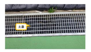
(写真3-3) 側溝内の土嚢の設置状況
