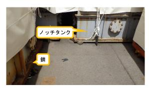
(写真4)錆が見られた収納容器 (ノッチタンク) の例
