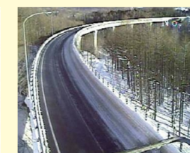
国道115号 土淵峠（横向大橋）
