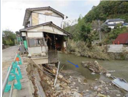
広瀬川(川俣町) 【東日本台風による被災状況】
