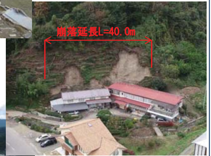
下名目津3号(二本松市) 【東日本台風による被災状況】
