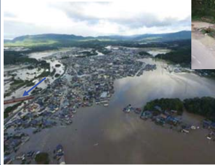
夏井川(いわき市) 【東日本台風による被害状況】
