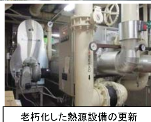
老朽化した熱源設備の更新
