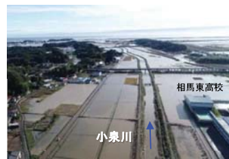
小泉川(相馬市) 【出水状況(R元.10月)】 洪水氾濫を防ぐための河川整備を推進
