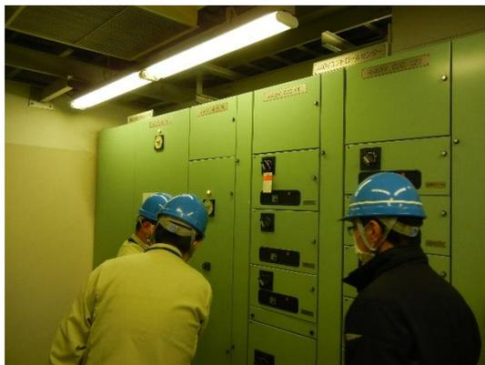
ポンプの電源設備を停止する様子
