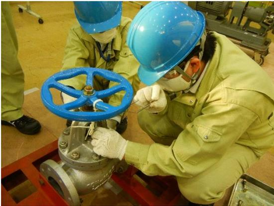
弁の分解点検実習（グランドパッキン挿入の様子）
