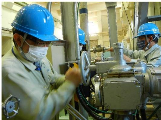
手動弁による弁操作の様子
