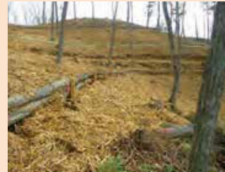
丸太筋工の設置
