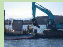
漁場内のがれき等の除去作業
