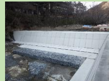
老朽化した頭首工の補修
