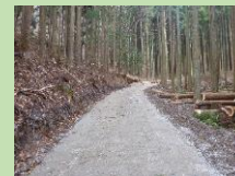
森林作業道の開設
