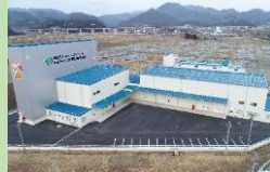
営農再開に向けた施設整備
