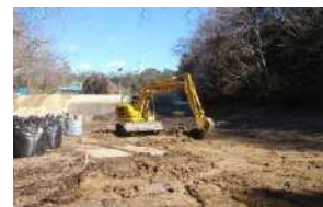
実施例③ 底質の掘削除去
