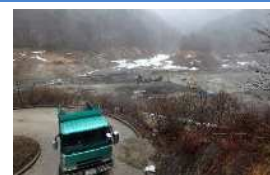
土砂運搬状況
