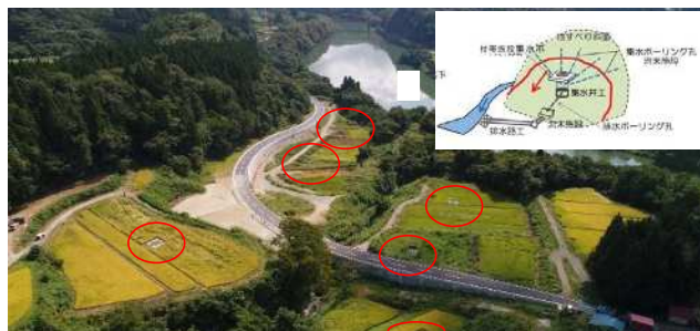
集水井設置 揚津地区（喜多方市）
