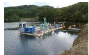
実施例④ ポンプによる浚渫除去
