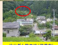
治山ダム施工地(伊達市)
