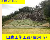
山腹工施工後(白河市)
