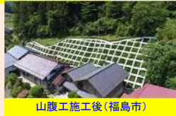
山腹工施工後(福島市)
