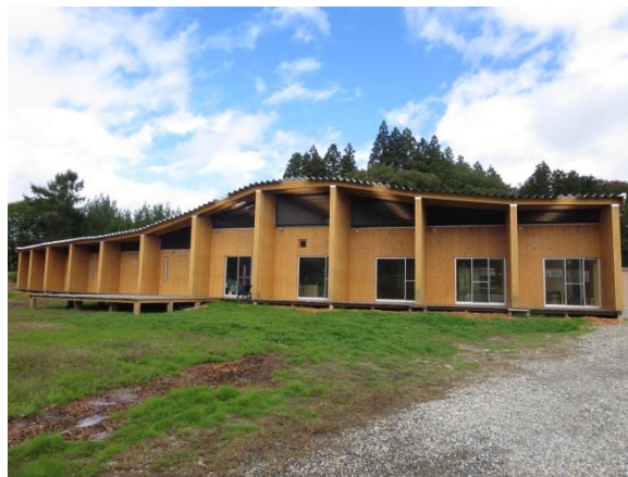
縦ログ工法による地域活動拠点・地域交流施設 （南会津町 ほしっぱの家）
