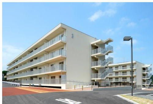
復興公営住宅（いわき市 宮沢団地）
