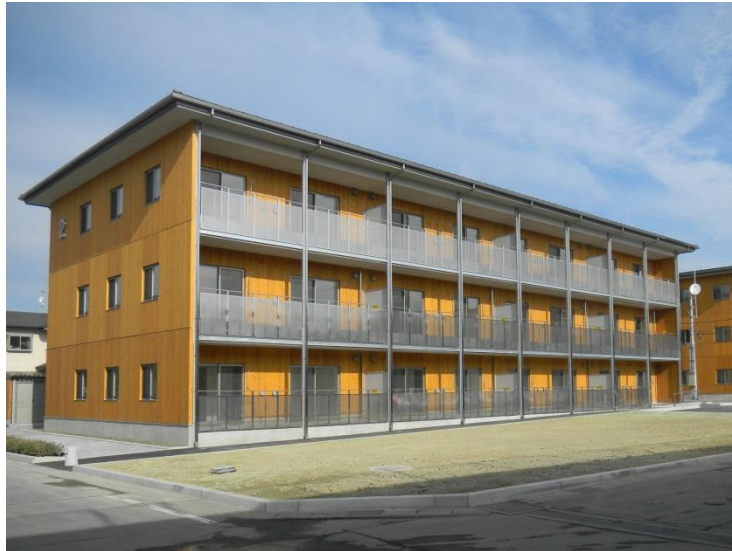
整備された復興公営住宅（いわき市 関船団地）
