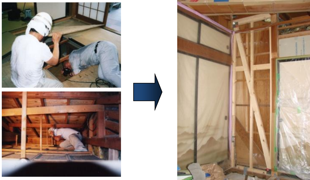
木造住宅の耐震診断、耐震改修状況
