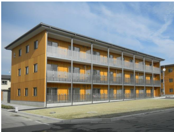
ウッドALCによる復興公営住宅（いわき市 関船団地）
