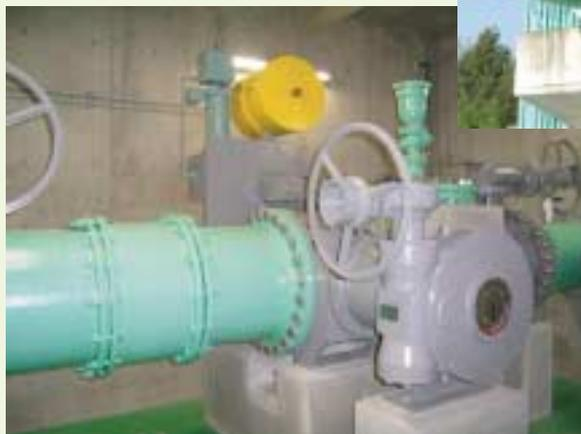
緊急遮断弁 (平野緊急遮断弁φ=1,100)
