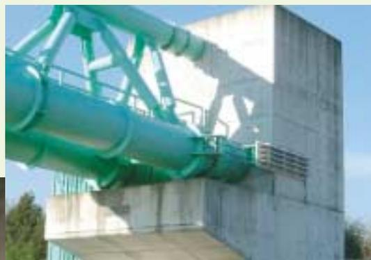
落橋防止装置 (松川水管橋)
