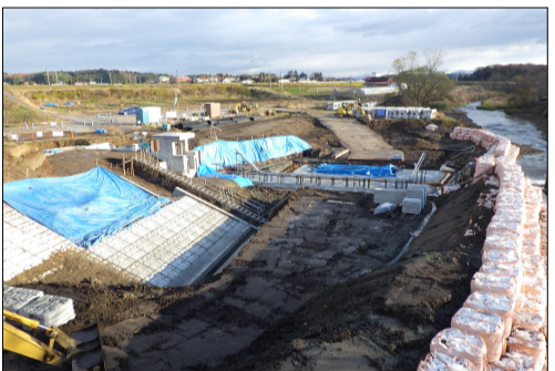
▲須賀川市仁井田大堰地区 復旧工事状況(R3.11月)
