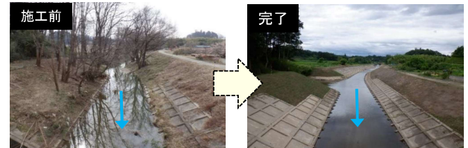
(河道掘削) 黒石川(福島市)
