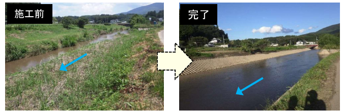
(河道掘削) 移川(田村市)
