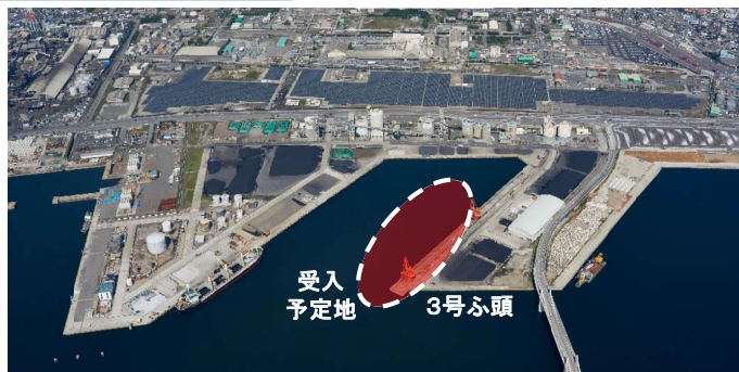
受入施設の整備 小名浜港3号ふ頭地区
