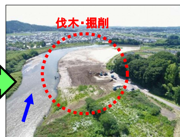
夏井川(いわき市) 【施工中状況】
