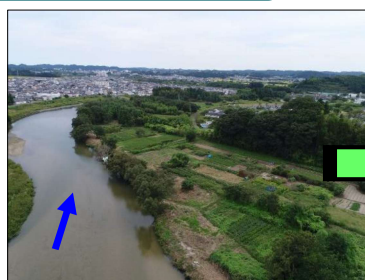
夏井川(いわき市) 【施工前状況】
