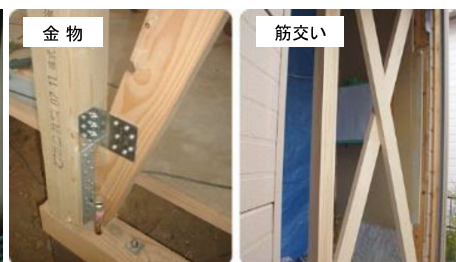
<耐震改修(補強)の事例>
