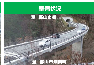
<郡山湖南線 三森I工区(郡山市)>
