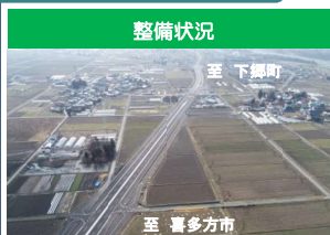
<国道118号 若松西バイパス供用区間>
