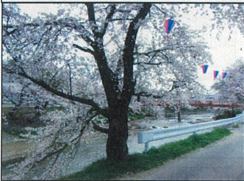
ガードレール
