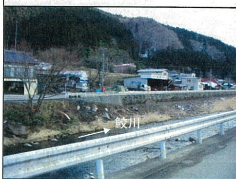
ガードレール
