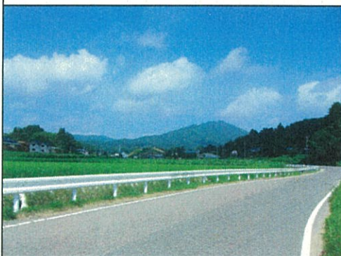
ガードレール
