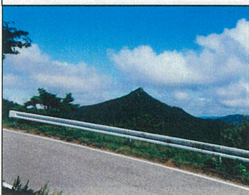
ガードレール
