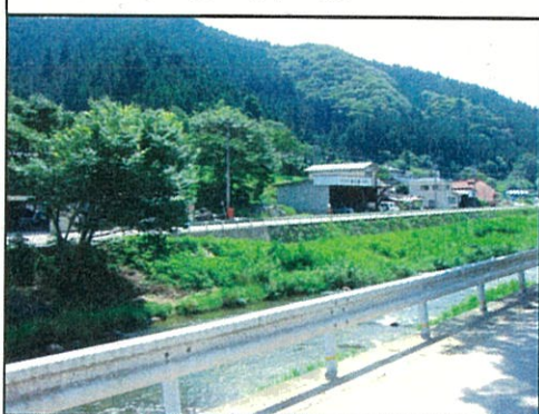
ガードレール
