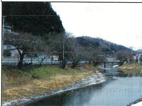
ガードレール
