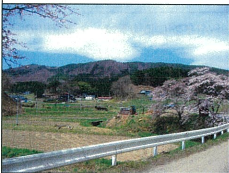
ガードレール
