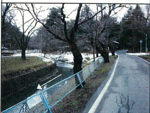
ガードパイプ
