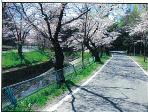
ガードパイプ
