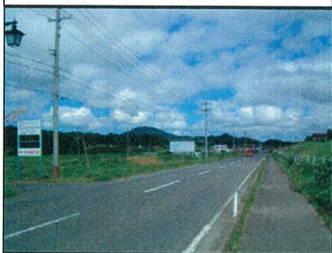
電柱・電線、ガードパイプ
