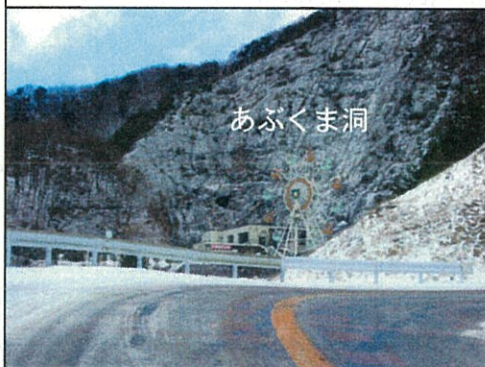
ガードレール
