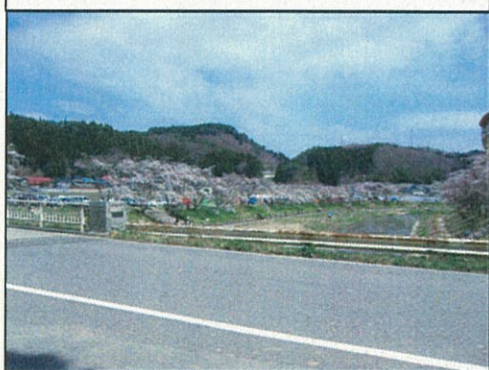
ガードレール
