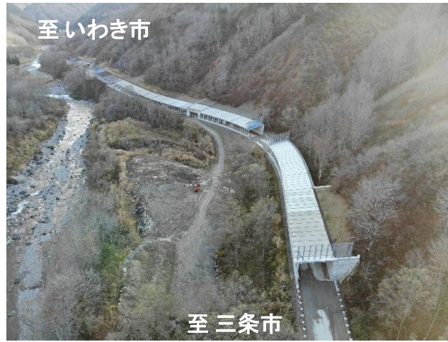
スノーシェッド工事状況
