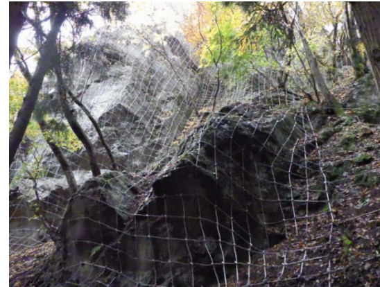
ロープネット工
