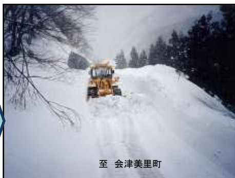
<試験除雪の取り組み状況(国道401号)>
