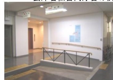
手すり・スロープで段差を解消
