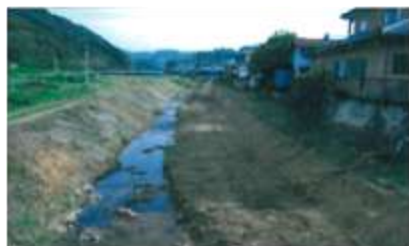
土砂を掘削し安全を確保
