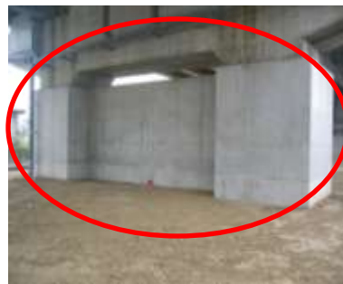
<橋りょうの耐震補強 整備例:施工後 (橋を支える柱の補強)>
