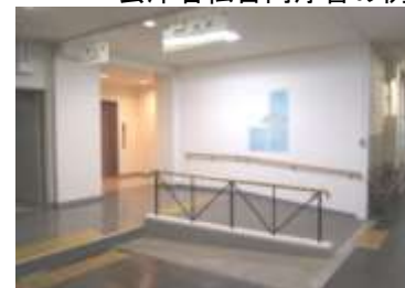
手すり・スロープで段差を解消
