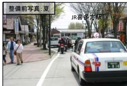
＜西小原北町線(喜多方駅前通り)整備前＞
