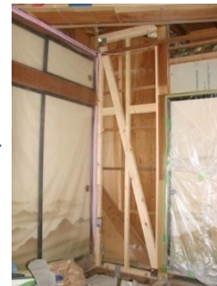
＜耐震改修事例：筋交い補強例＞
