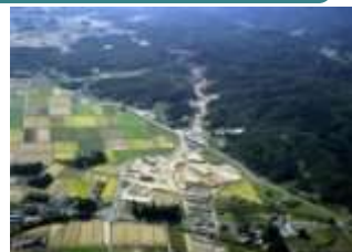
【常磐自動車道 (仮)原町ICの状況】
