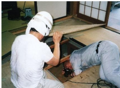
＜木造住宅耐震診断の実施＞
