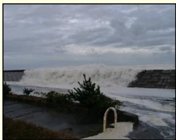
木崎海岸 越波状況
