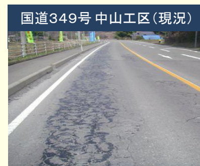
舗装の損傷箇所を補修します
