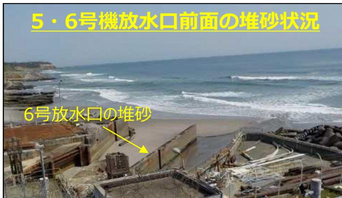
5・6号機放水口前面は、堆砂により水深が浅く陸域化している状況。
