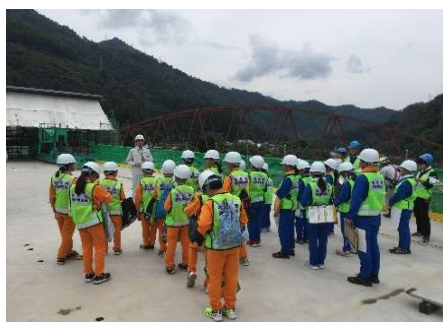
現場説明の様子
