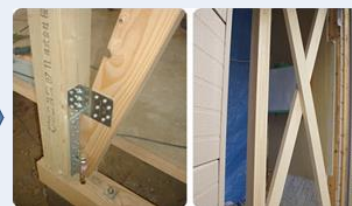
（耐震改修の事例）
