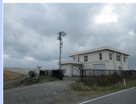
(↑) 村上第二排水機場の写真
